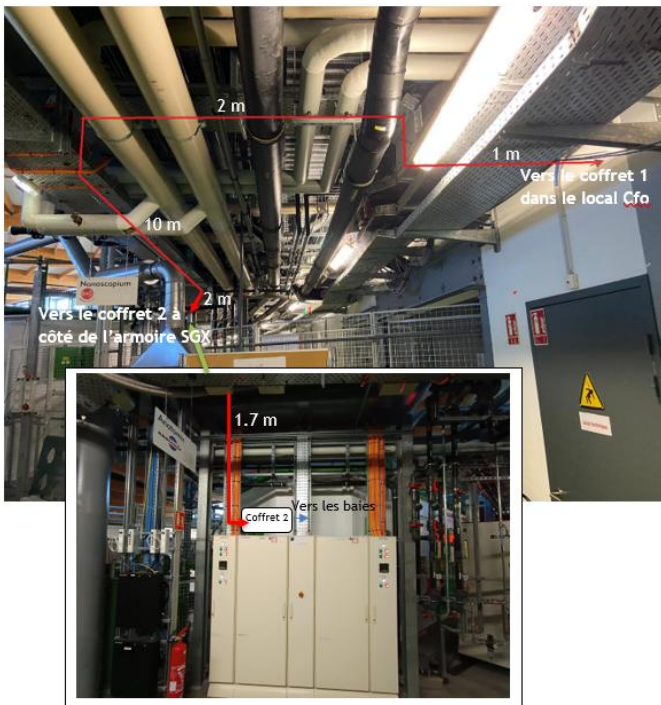
FIGURE 4 : LIAISON COFFRET 1 - COFFRET 2
